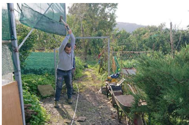
Figura 2-2– Esempio di esecuzione prova sismica a rifrazione
