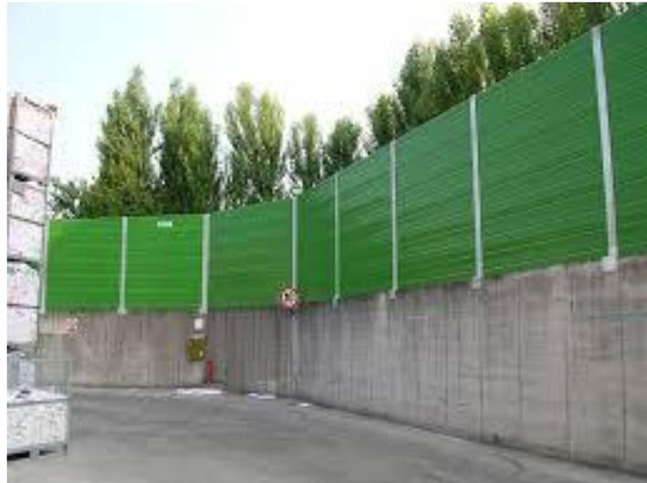
Figura 4-3 - Esempio di installazione di barriera fonoassorbente
