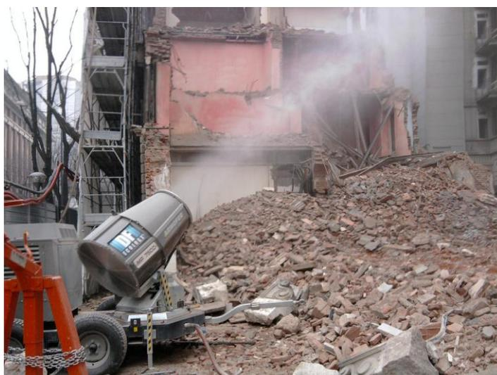
Figura 4-1 - Esempio di impiego di cannone nebulizzatore nei cantieri edili
