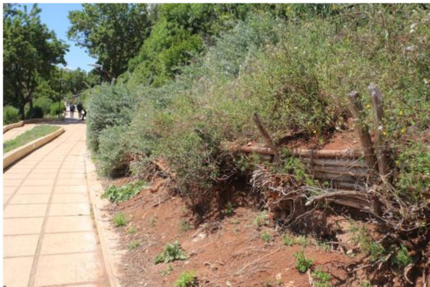
Figura 1.5 – Lo scivolamento dei materiali ha interessato la strada interna al lungomare provocando smottamenti di piccole dimensioni.
