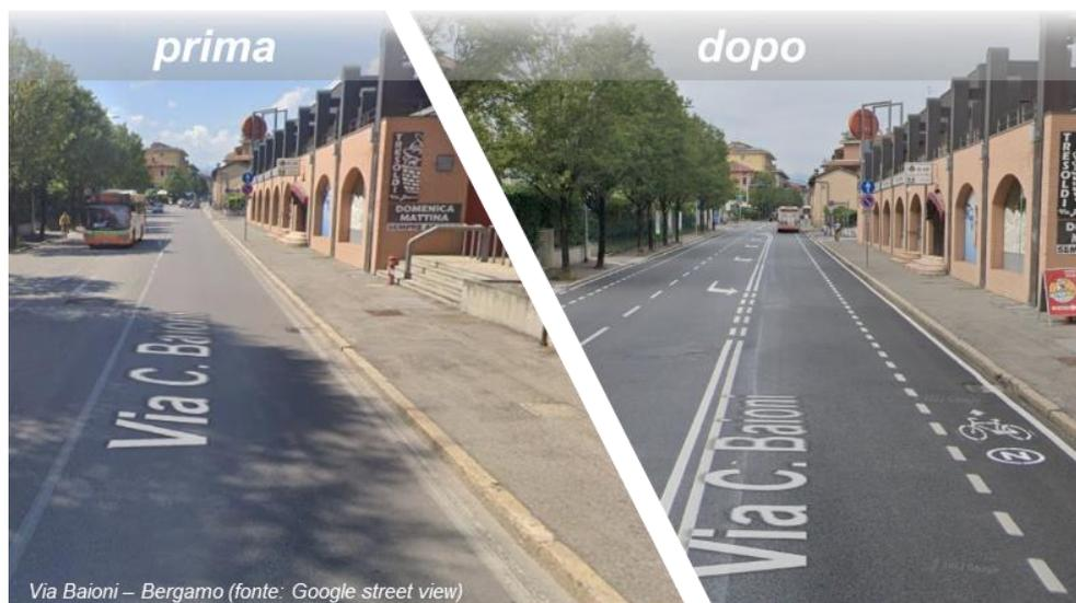
Figura 83 Esempio di applicazione di corsia ciclabile
