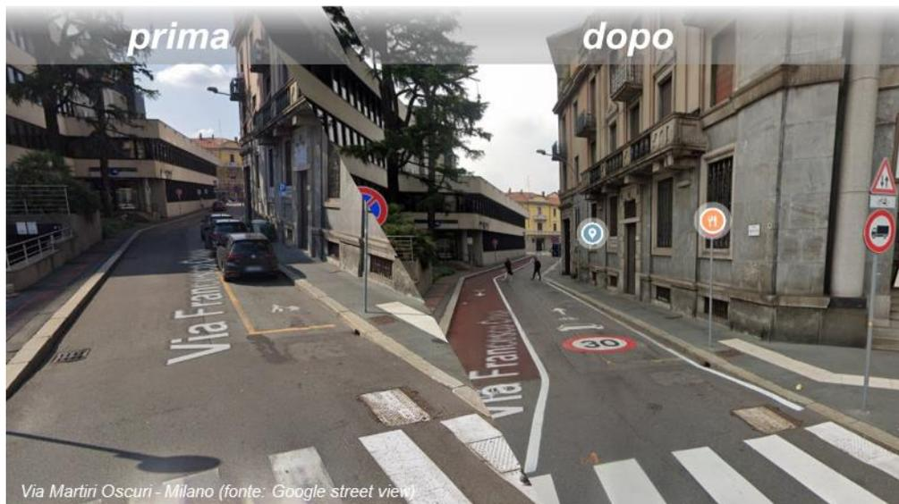
Figura 88 Esempio di applicazione di corsia ciclabile per doppio senso ciclabile
