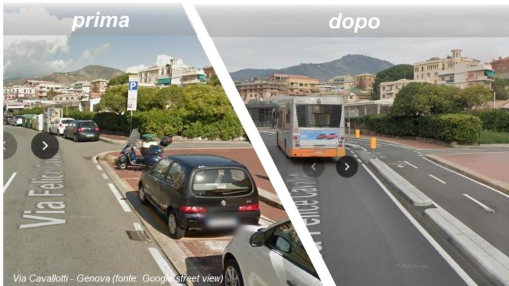
Figura 71 Esempio di applicazione di pista ciclabile in sede propria con separazione invalicabile
